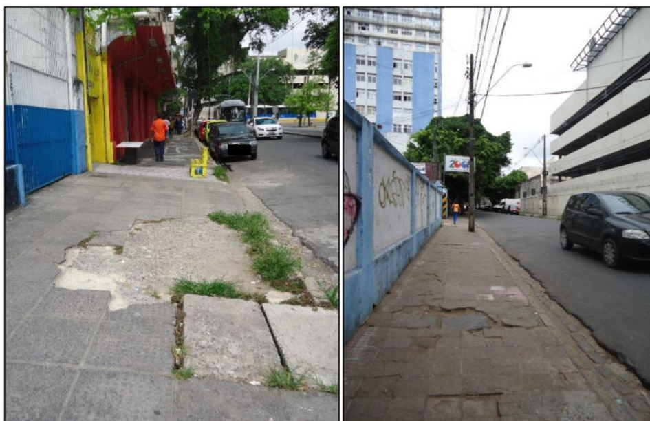
Figura 14 - Pavimento em lajota danificado
