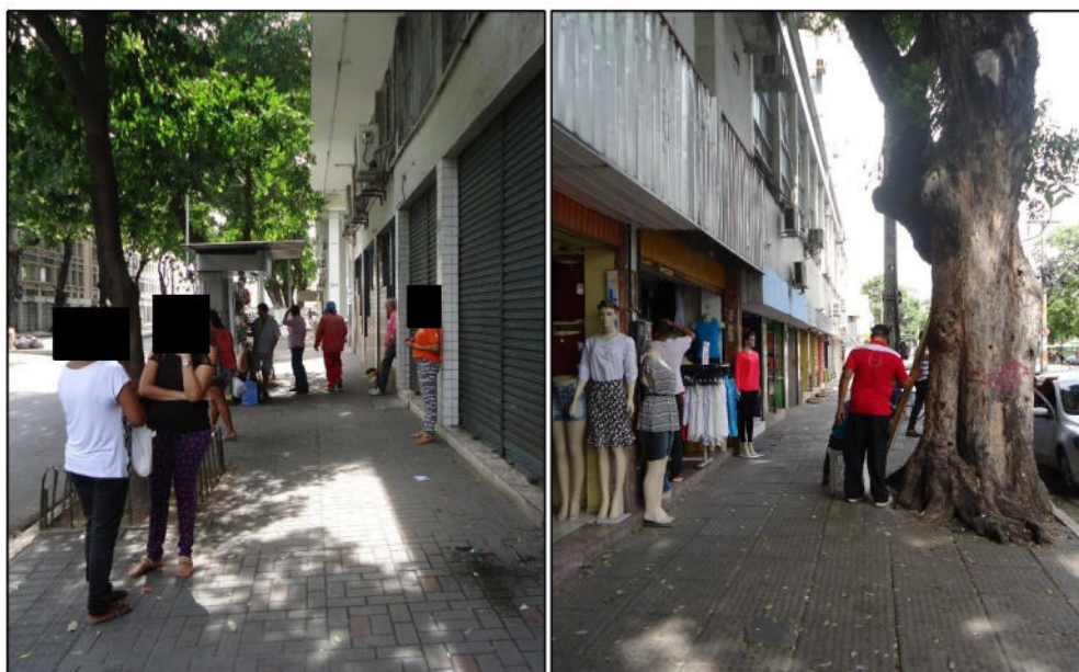
Figura 8 - Pavimento em intertravado / Figura 9 - Pavimento em Lajota
