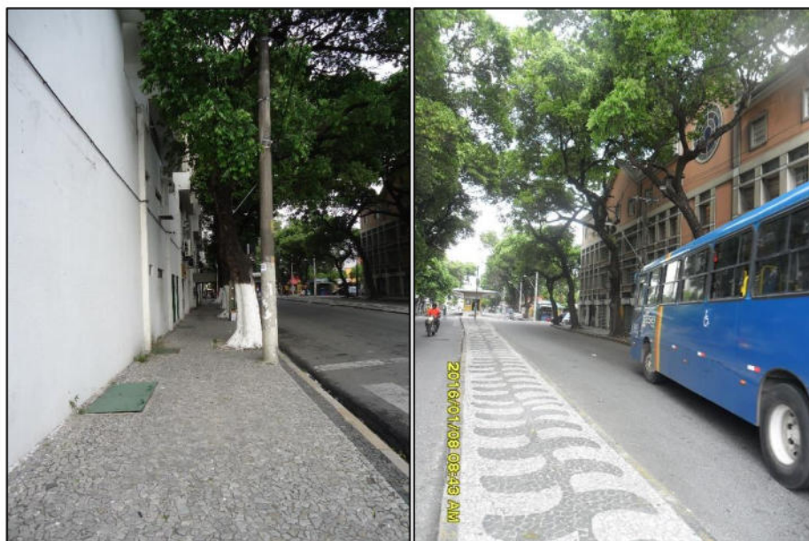
Figura 6 - Pavimento em pedras portuguesas / Figura 7 – Canteiro Central – Pavimento em pedra portuguesa
