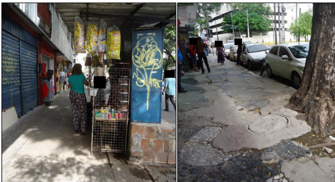
Figura 12 - Ocupação irregular do passeio / Figura 13 - Remendos no passeio
