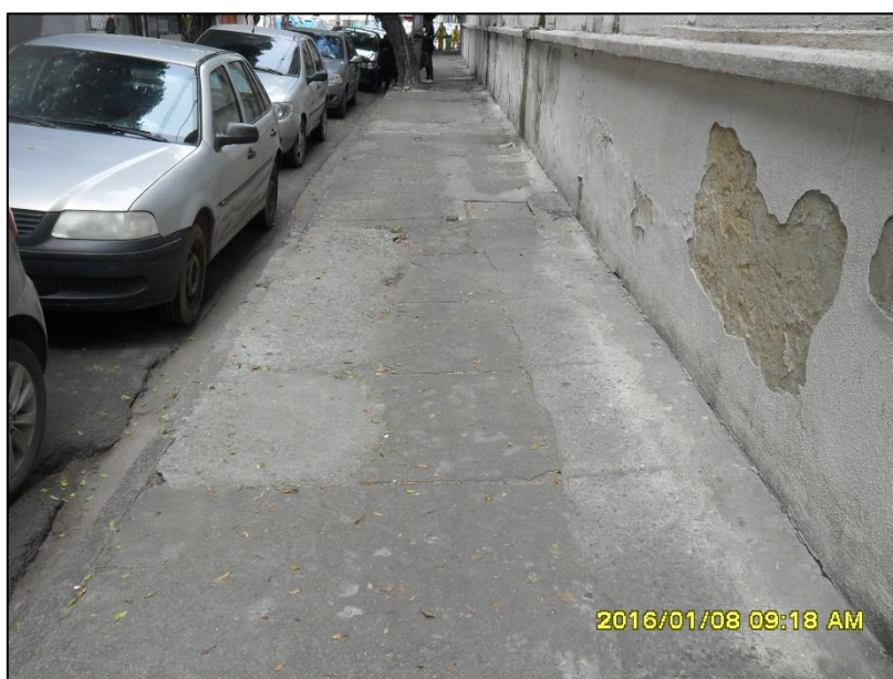
Figura 11 - Pavimento em piso cimentado
