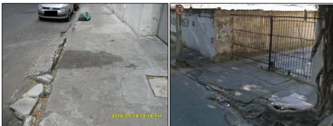
Figura 20 - Situação Atual: Linha d' água obstruída por rampa de acesso e vegetação.
