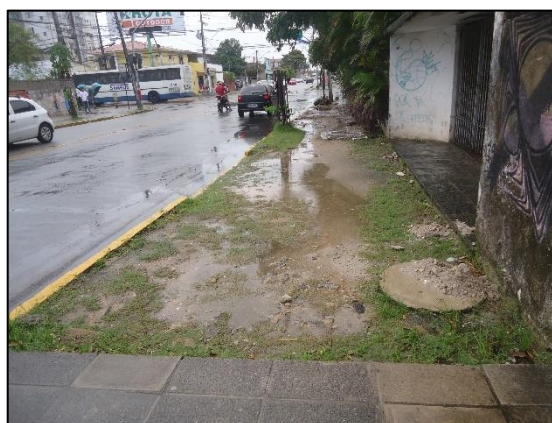
Figura 11 - Ausência de pavimento
