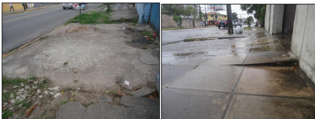
Figura 5– Pavimento em Concreto / Figura 6 - Pavimento em Lajota
