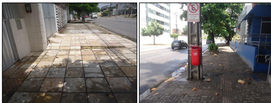
Figura 9 - Pavimento em cerâmica / Figura 10 - pavimento em intertravado
