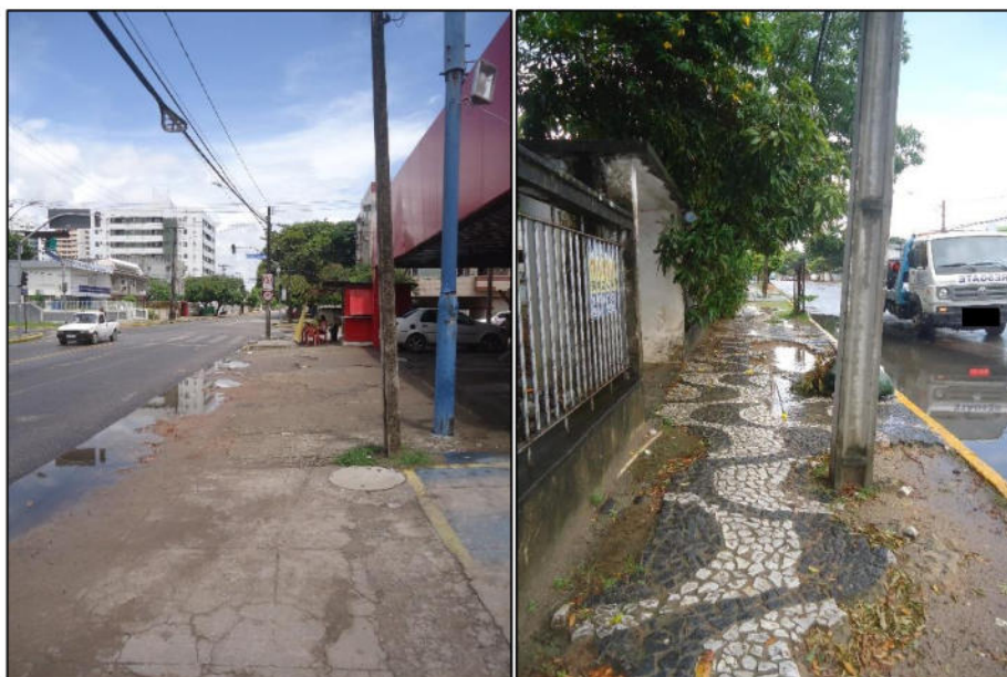
Figura 7 - Pavimento em piso cimentado / Figura 8 - Pavimento em pedras portuguesas
