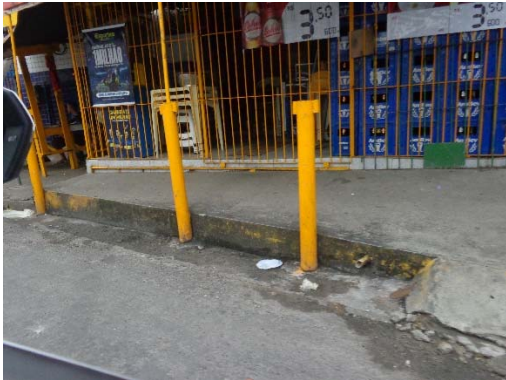
Figura 14 - Revestimento em concreto simples (Fonte: Future ATP – MAI/2021)
