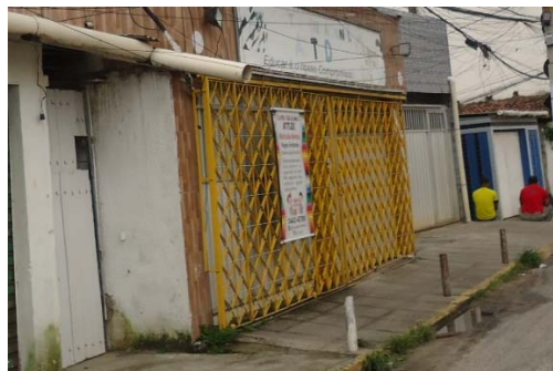
Figura 16 - Revestimento em placas de concreto (Fonte: Future ATP – MAI/2021)
