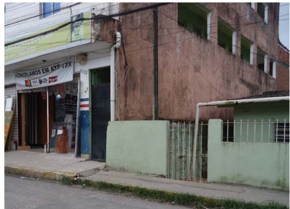
Figura 6 – Desnível entre calçadas com descontinuidade do passeio
