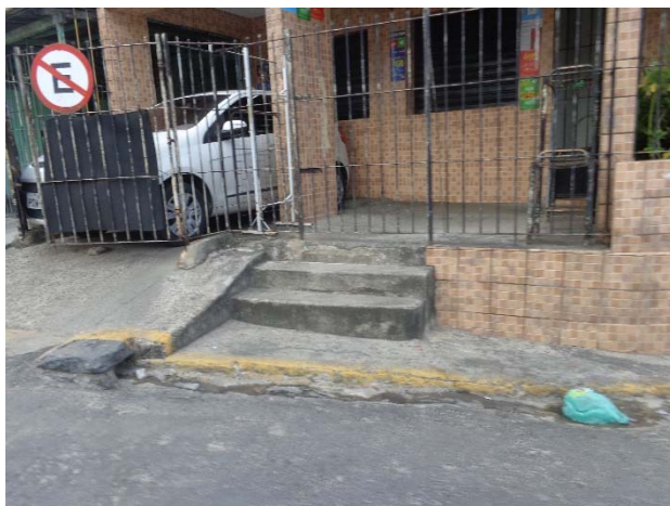
Figura 18 - Drenagem: linha d'água obstruída
