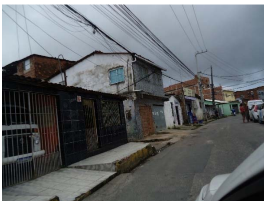
Figura 3 – Grande desnível entre calçada e a via (Fonte: Future ATP – MAI/2021)
