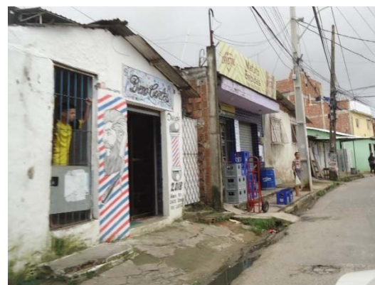
Figura 4 – Desnível entre calçadas, com descontinuidade do passeio (Fonte: Future ATP – MAI/2021)
