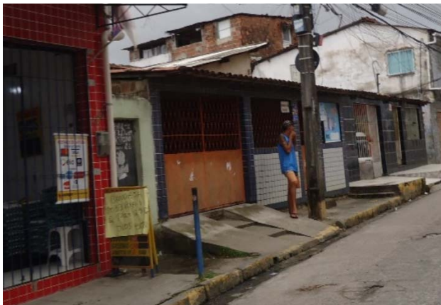
Figura 5 – Rampa de veículos e balizador de ferro obstruindo o passeio
