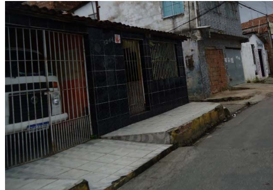
Figura 15 - Revestimento cerâmico (Fonte: Future ATP – MAI/2021)
