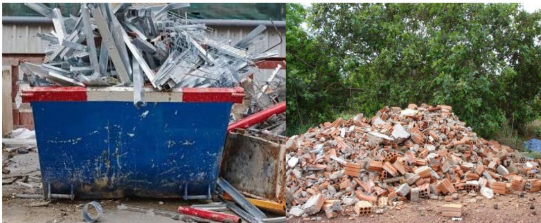
Figura 3 - Imagens ilustrativas de volumes de entulhos provindos perdas durante os processos construtivos.
