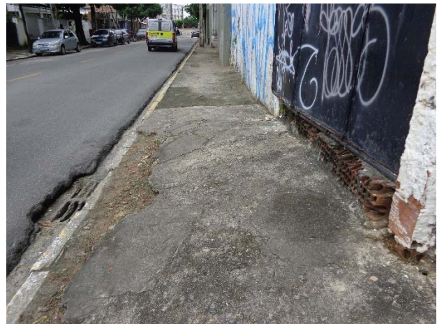
Figura 22 - Drenagem: Caixa coletora obstruída (Fonte: Future ATP – JAN/2021)
