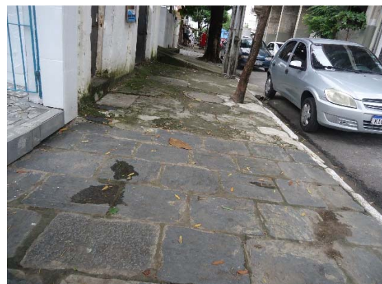
Figura 19 - Revestimento em pedra lajão (Fonte: Future ATP – MAI/2021)
