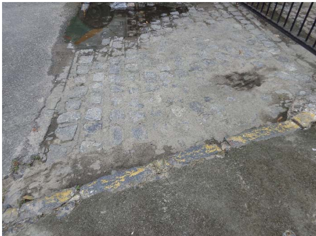
Figura 21 - Drenagem: linha d'água obstruída (Fonte: Future ATP – JAN/2021)
