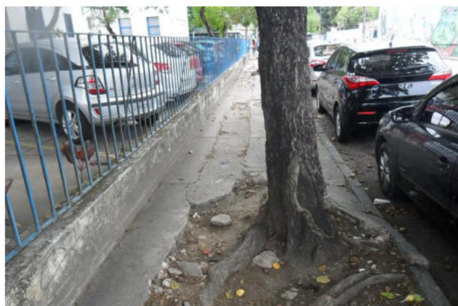
Figura 2 – Calçada da Escola de Contas Públicas
