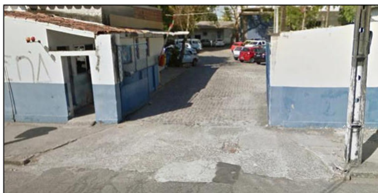
Figura 18 - Situação Atual : Linha d' água obstruída por acesso ao estacionamento, que podem provocar alagamentos.
