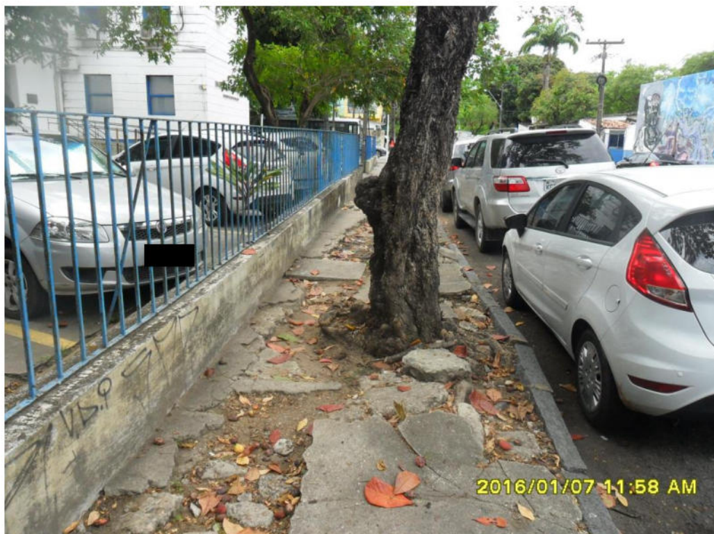
Figura 8 - Árvores A3 e A4, localizada em frente ao escritório da Compesa
