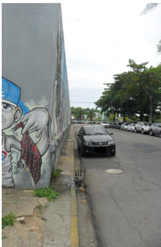
Figura 1 – Calçada da COMPESA
