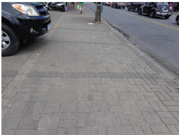
Figura 11 - Revestimento em intertravado (Fonte: Future ATP – MAI/2021)
