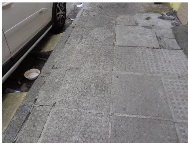
Figura 13 - Revestimento em placas de concreto (Fonte: Future ATP – MAI/2021)
