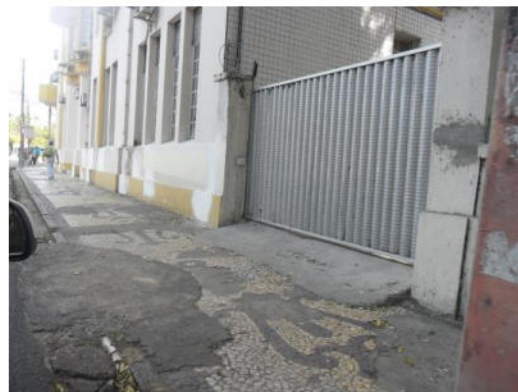
Figura 22 - Situação Atual : Linha d'água obstruída por vegetação e por rampa de acesso ao estabelecimento, podendo provocar pontos de alagamentos.
