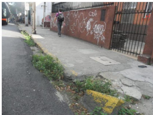
Figura 22 - Situação Atual : Linha d'água obstruída por vegetação e por rampa de acesso ao estabelecimento, podendo provocar pontos de alagamentos.
