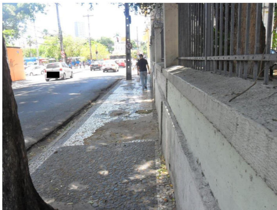
Figura 19 – Revestimento misto em Pedra Portuguesa e Pedra Mineira
