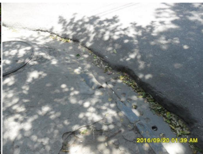
Figura 23 ituação Atual : Boca-de-Lobo totalmente obstruída por folhas e lixo, podendo provocar pontos de alagamentos, devido ao comprometimento da capacidade hidráulica das caixas.
