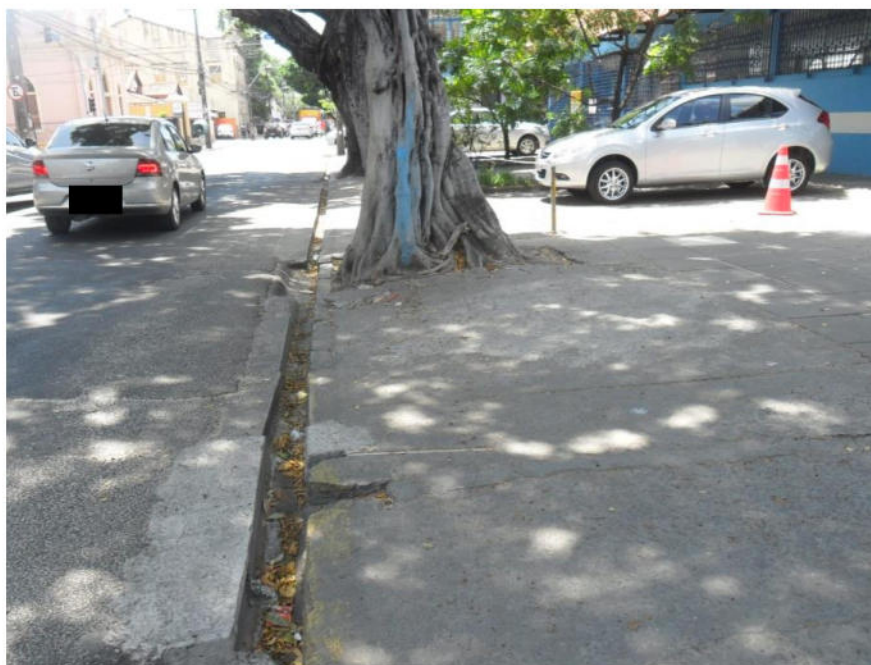
Figura 17- Revestimento em concreto
