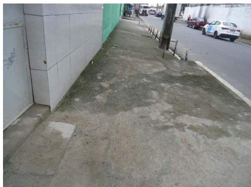
Figura 12 - Revestimento em concreto simples (Fonte: Future ATP – MAI/2021)
