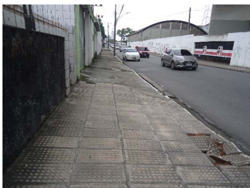
Figura 14 - Revestimento em placas de concreto (Fonte: Future ATP – MAI/2021)
