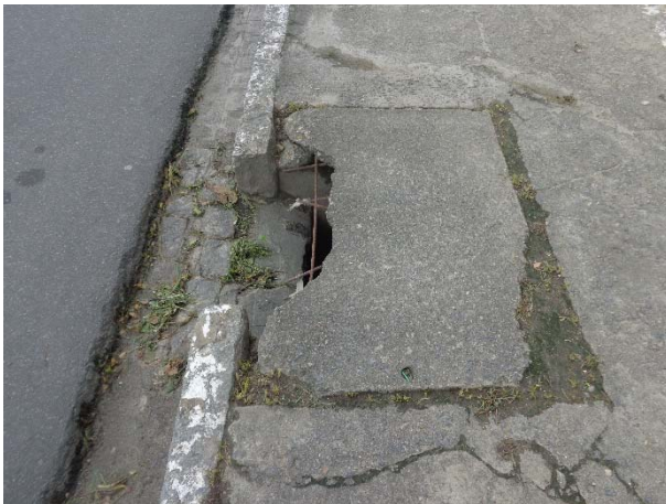
Figura 17 - Drenagem: Caixa coletora obstruída (Fonte: Future ATP – JAN/2021)
