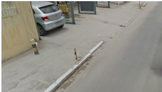
Foto 1 – Situação Atual: Caixa tipo boca-de-lobo obstruída. Linha d' água obstruída por vegetação, provocando pontos de alagamentos, e destruída.
