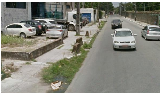
Foto 3 – Situação Atual: Caixa tipo gaveta obstruída com tampa destruída. Linha d' água obstruída por vegetação.
