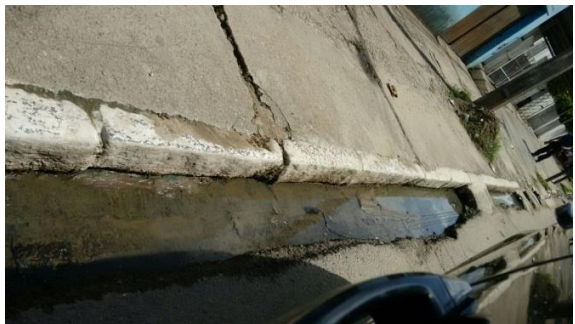
Foto 2 – Situação Atual: Meio-fio destruído e obstrução da linha d' água por rampa de acesso, provocando alagamento.
