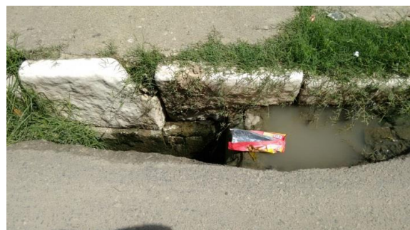
Foto 1 – Situação Atual: Caixa tipo boca-de-lobo obstruída. Linha d' água obstruída por vegetação, provocando pontos de alagamentos, e destruída.
