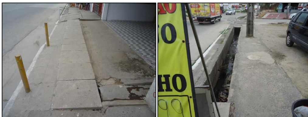
Figura 14 – Placas de Concreto Armado / Figura 15 – Canal Aberto no Passeio
