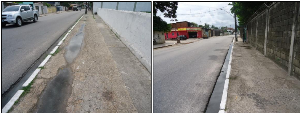
Figura 10 - Pavimento em piso cimentado / Figura 11 - Pavimento em concreto
