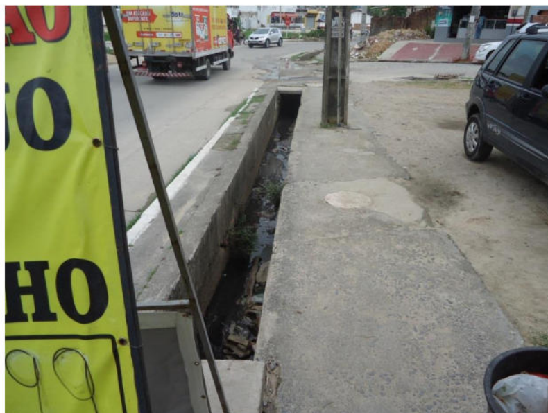
Figura 2 – Canaleta sob a calçada
