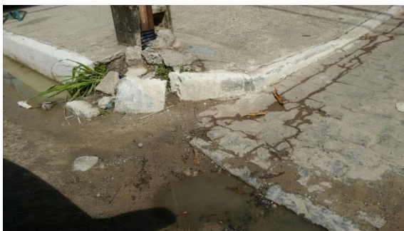
Foto 2 – Situação Atual: Meio-fio destruído e obstrução da linha d' água por rampa de acesso, provocando alagamento.
