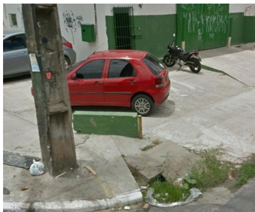
Foto 3 – Situação Atual: Caixa tipo gaveta obstruída com tampa destruída. Linha d' água obstruída por vegetação.
