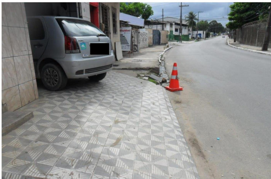
Figura 1 – rampa de acesso de veículos ocupando todo o passeio
