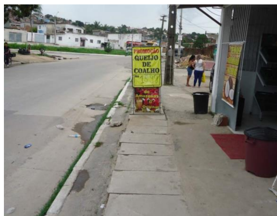
Foto 4 – Situação Atual: Canaleta aberta na calçada e tampa da canaleta na calçada danificada.
