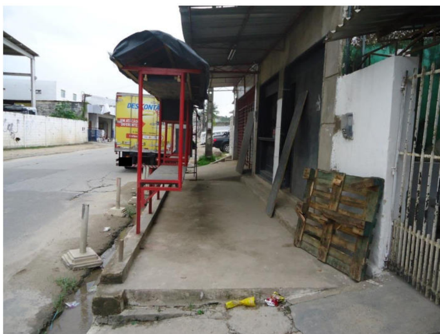
Figura 4 - Barracas de comércio com cobertas obstruindo o passeio
