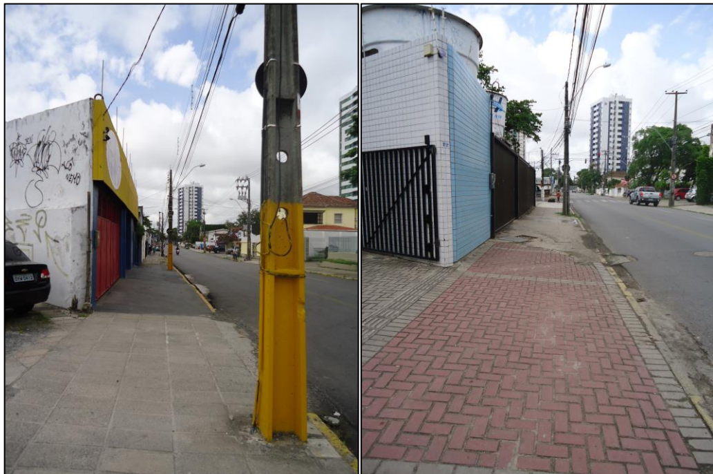
Figura 6 - Passeios em lajota e cimentado / Figura 7 - Passeio em intertravado
