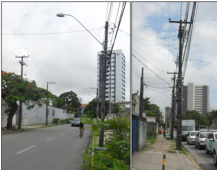
Figura 25 – Postes de concreto nos passeios
