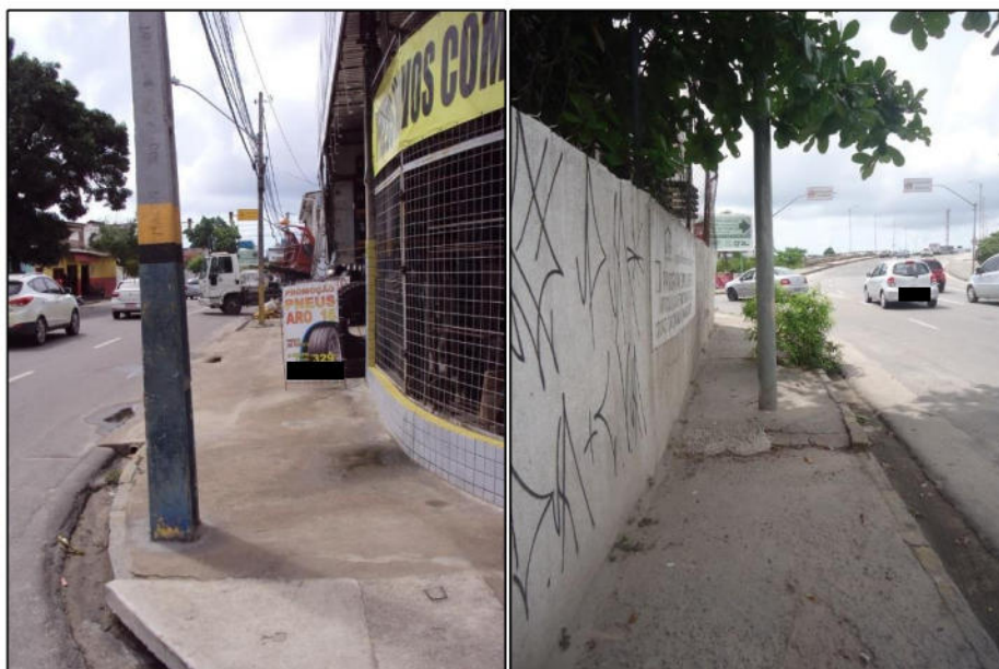
Figura 4 - Pavimento em piso cimentado / Figura 5 - Pavimento em concreto
