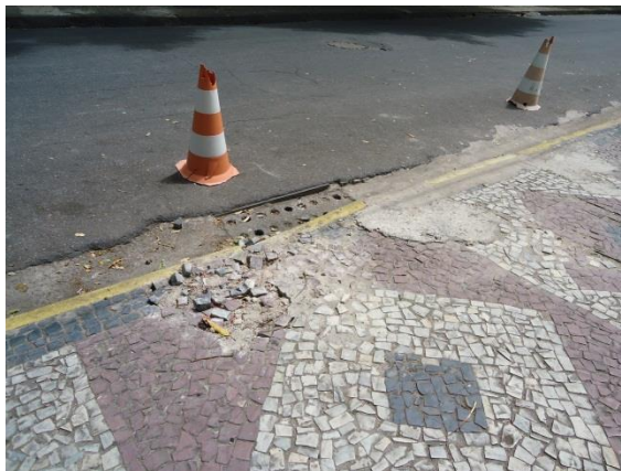
Foto 2 – Situação Atual: Tampa tipo boca-de-lobo obstruída e linha d' água obstruída por rampa de acesso.
