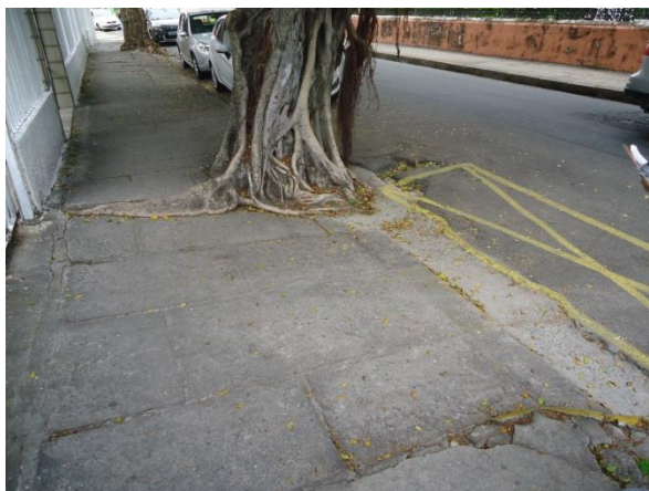
Foto 3 – Situação Atual: Linha d' água obstruída por rampa de acesso e vegetação.
