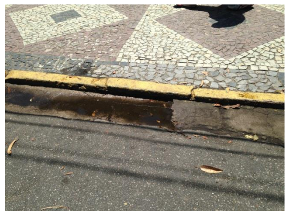
Foto 2 – Situação Atual: Tampa tipo boca-de-lobo obstruída e linha d' água obstruída por rampa de acesso.
