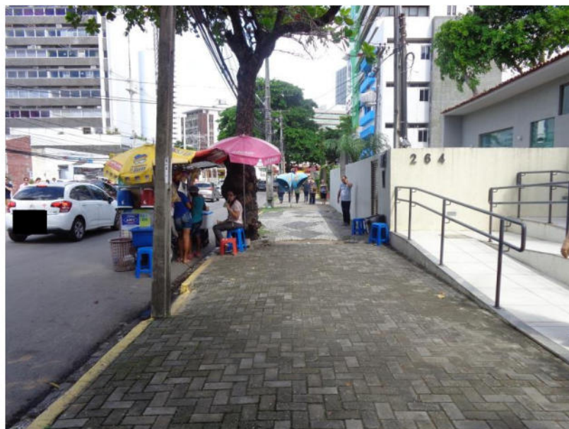
Figura 7- Revestimento em bloco intertravado
