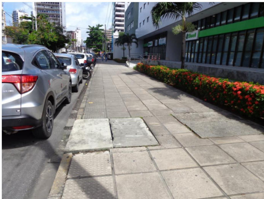
Figura 6- Revestimento em lajotas
