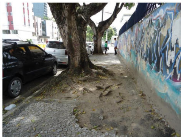
Figura 2 – Calçada da Escola Estadual Cônego Rochael
