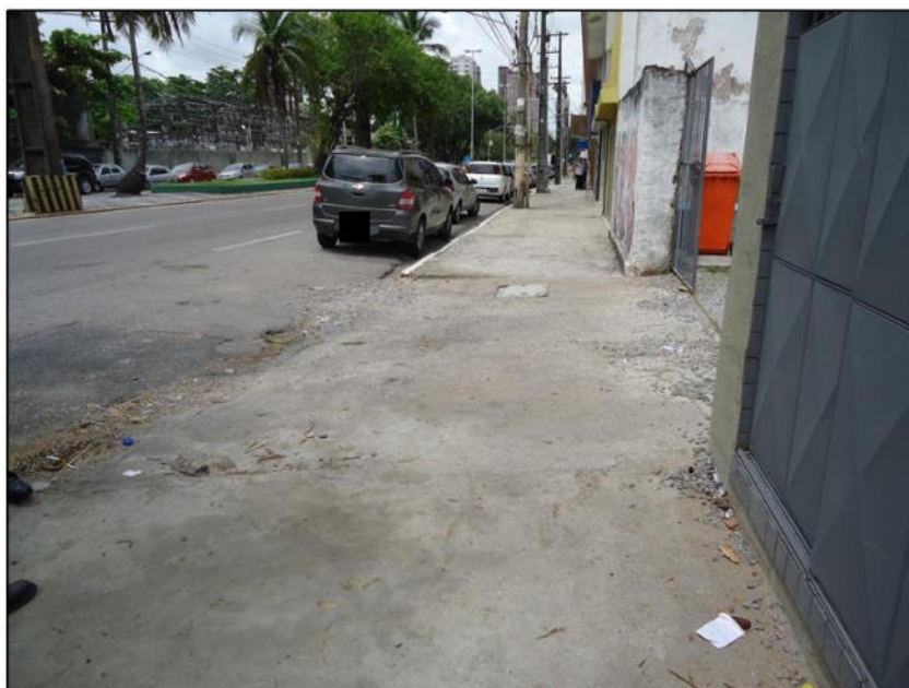
Figura 6 - Pavimento em Concreto
