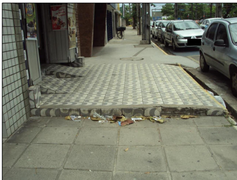
Figura 7 - Pavimento em Cerâmica e Lajota
