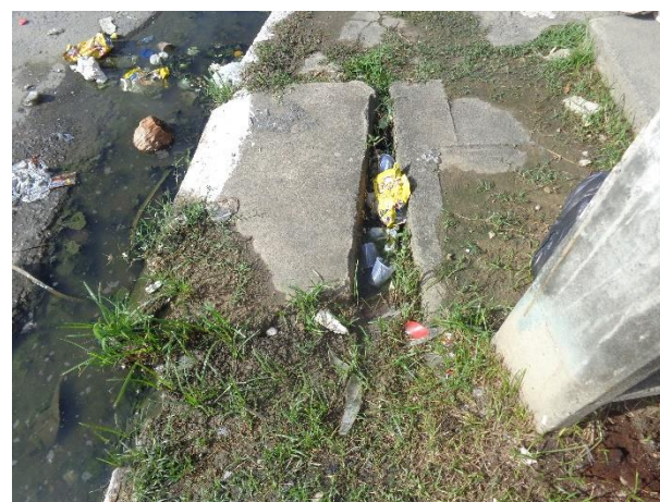
Figura 17 - Drenagem: Caixa coletora obstruída (Fonte: Future ATP – JAN/2021)
