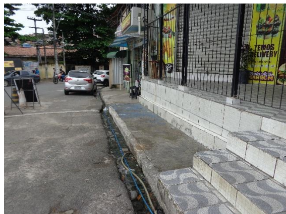
Figura 14 - Revestimento em piso cerâmico (Fonte: Future ATP – MAI/2021)
