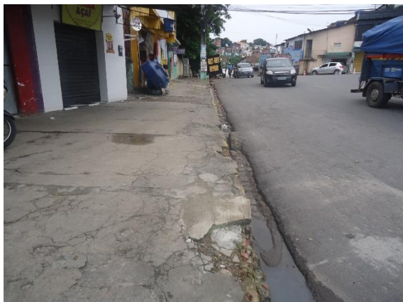
Figura 13 - Revestimento em concreto simples (Fonte: Future ATP – MAI/2021)
