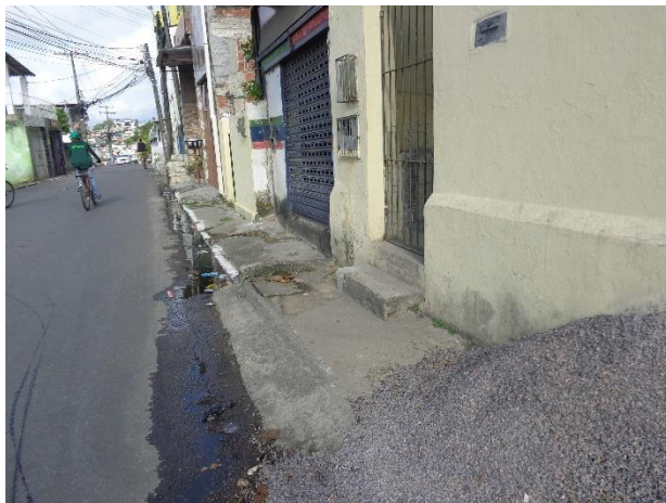
Figura 16 - Drenagem: linha d'água obstruída (Fonte: Future ATP – JAN/2021)
