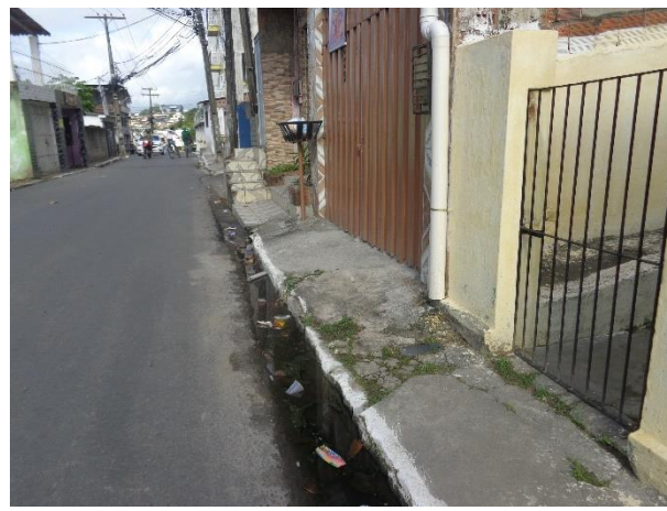
Figura 16 - Drenagem: linha d'água obstruída (Fonte: Future ATP – JAN/2021)
