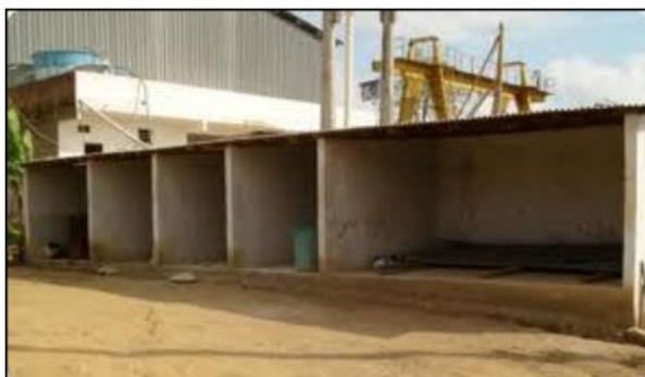
Figura 2 – Modelo de baias utilizadas para o armazenamento final de alguns resíduos no canteiro de obras
