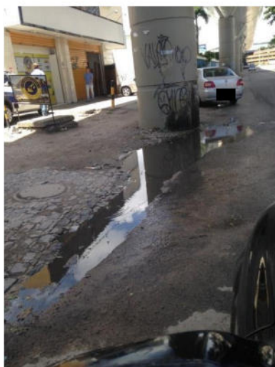
Figura 14 – Situação Atual : Pontos de alagamento, devido as rampas de acesso aos estabelecimentos.
