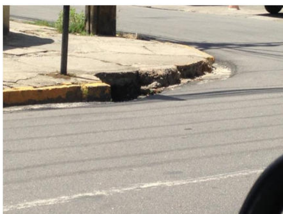
Figura 15– Situação Atual : Linha d' água destruída pela erosão, e pontos de alagamento. E caixa com tampa destruída.
