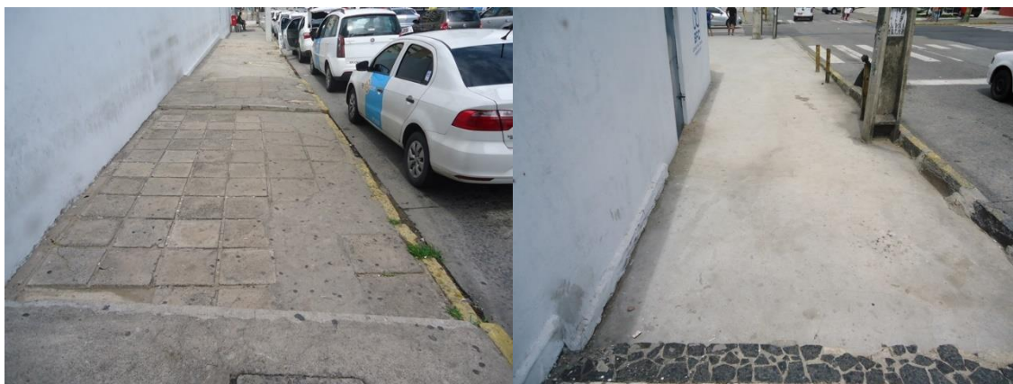
Figura 8 - Pavimento em Lajotas de Concreto/ Figura 9 - Pavimento em Concreto
