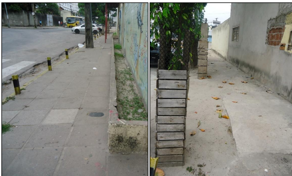
Figura 8 – Pavimento em lajotas / Figura 9 - Pavimento em concreto
