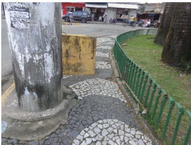
Figura 3 – Barreira “new Jersey” obstruindo o passeio (Fonte: Future ATP – MAI/2021)
