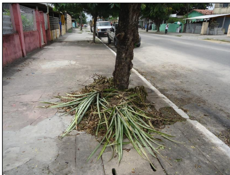
Figura 10 - Pavimento em piso cimentado
