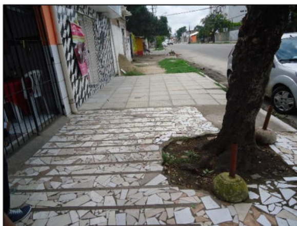
Figura 11 - Pavimento em cerâmica
