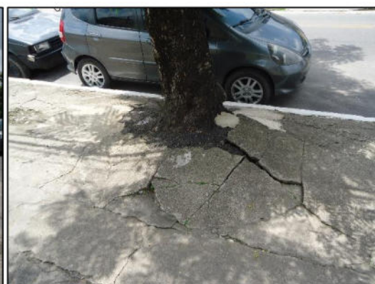
Figura 13 - Pavimento danificado / Figura 14 - Pavimento danificado pelas raízes de árvores
