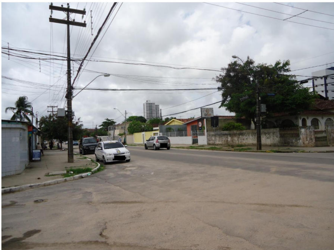
Figura 16 - Postes no passeio
