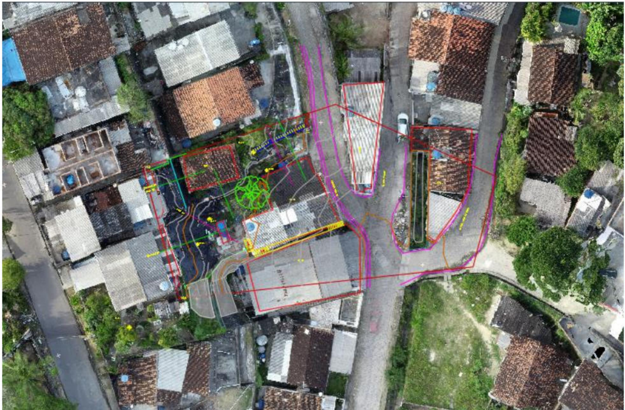
Figura 5: Destocamento de árvore - encosta - Rua Engenheiro Navarro Nº 30 - Sítio Do Rosário - RPA 2, Recife - PE.
