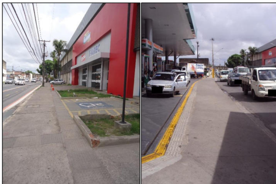
Figura 4 - Pavimento cimentado com piso direcional / Figura 5 - Pavimento em Piso cimentado
