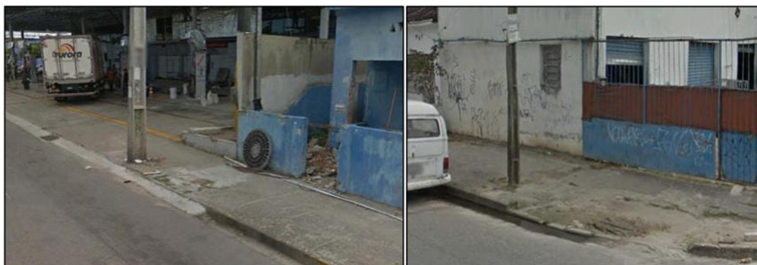
Figura 10 - Situação Atual : Pontos de obstruções que podem provocar alagamento, devido às rampas de acesso aos estabelecimentos.
